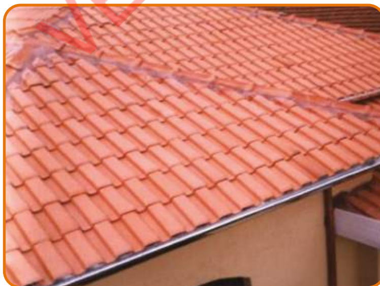
Figura 4B - Telhas feitas com barro
